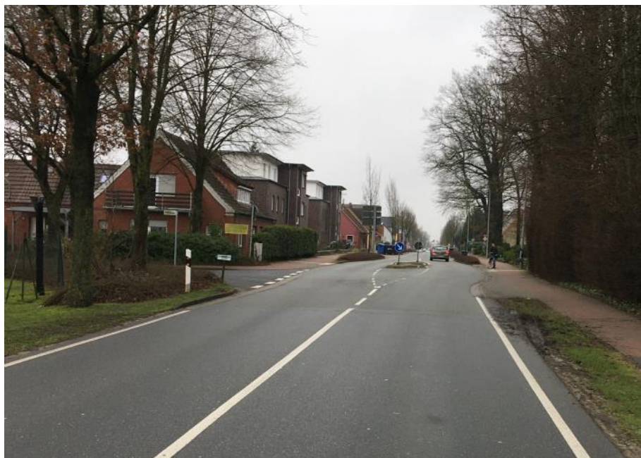
Bahnhofstraße (B 71) Blickrichtung Nord
