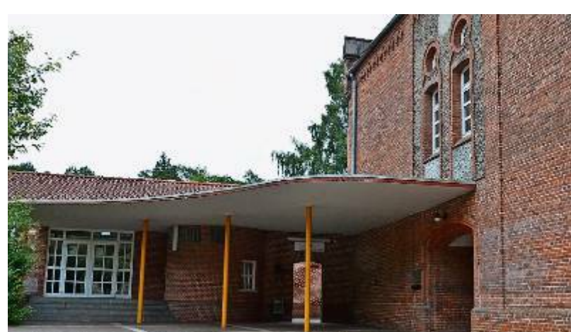
Der Anbau neben dem Durchgang zur Turnhalle und das geschwungene Vordach werden weichen müssen. Foto: Kratzmann
